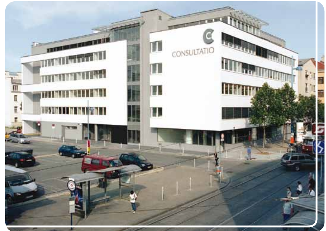
Das neue Bürogebäude von Consultatio in Wien wurde komplett mit memon® Transformern ausgestattet. Eine Investition in die Zukunft und das Wohlergehen der Mitarbeiter
